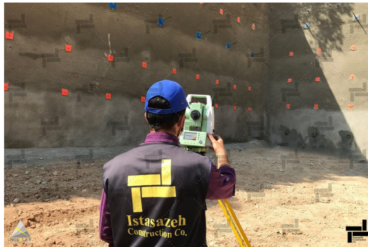
مرحله ۴ گزارش روند تغییر مکان های به سمت گود و نشست آن
