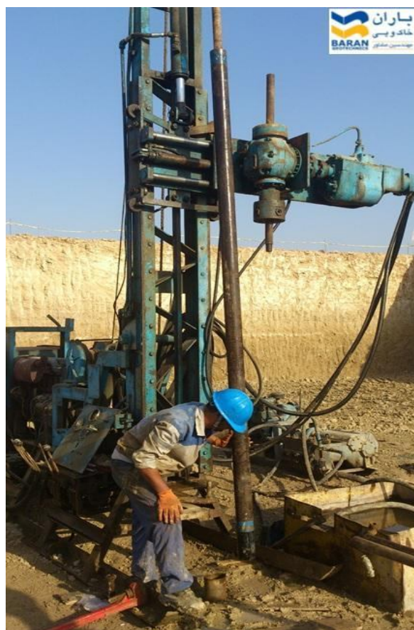
شکل ۸: نمونه گیری توسط کربارل دابل
